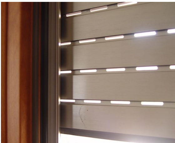
Détail des lames ajourées pour aération/lumière
